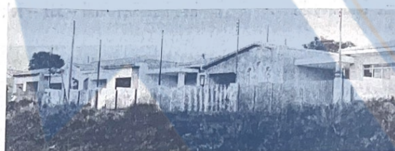
Belíssimas residências em fase de acabamentos
